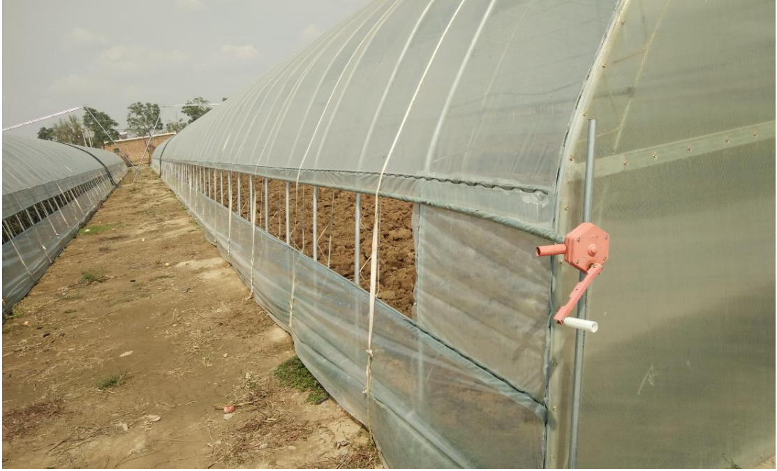
大棚拱架下风口手动卷膜器安装效果示意
