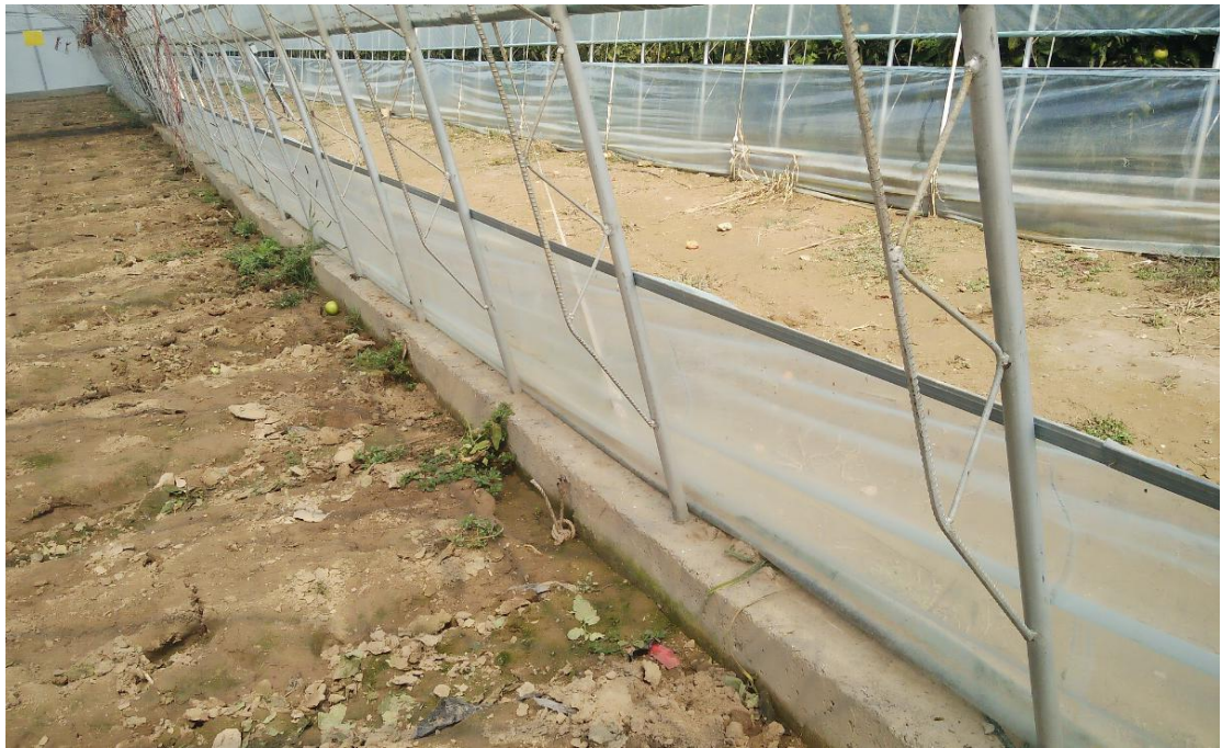
镀锌钢桁架式拱架效果示意
