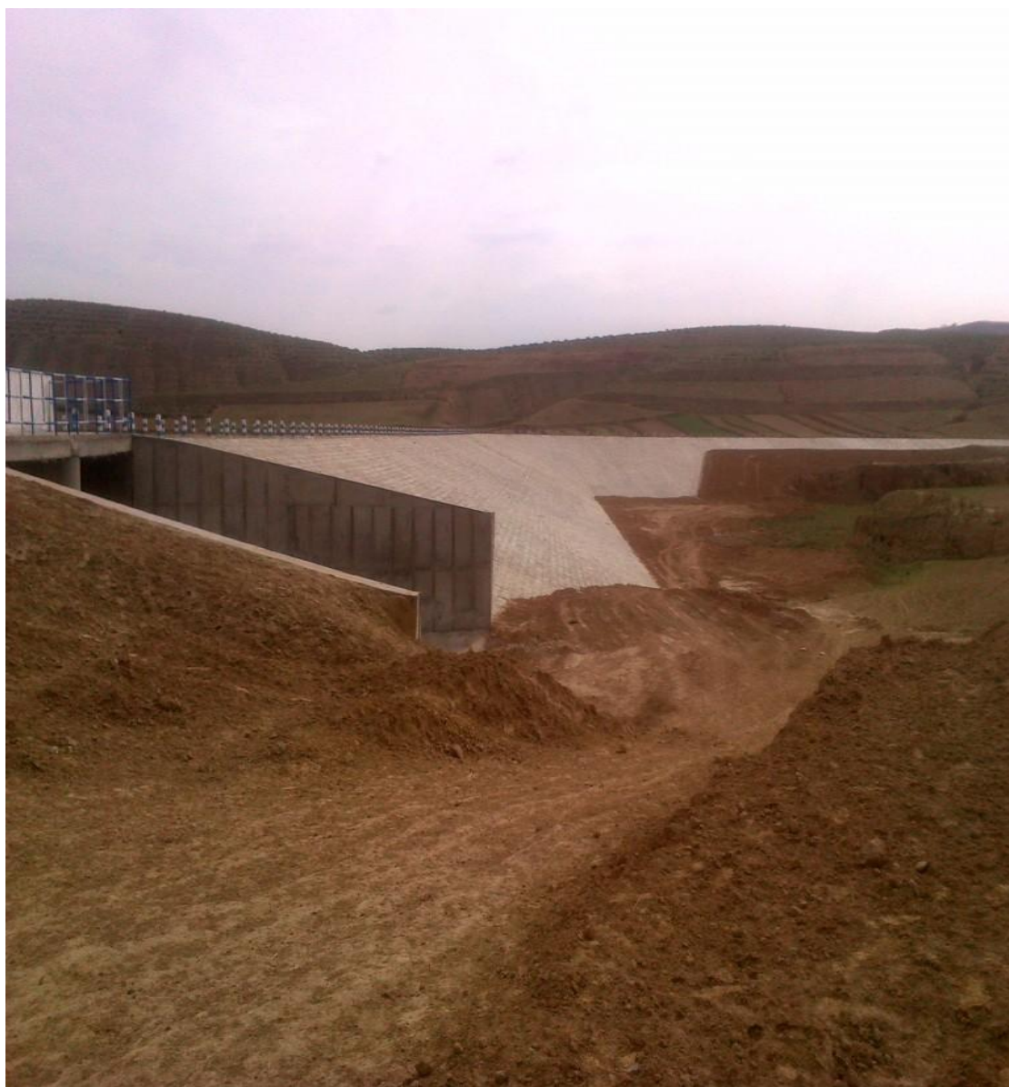
图 5-13 罗泉湾水库全景照
