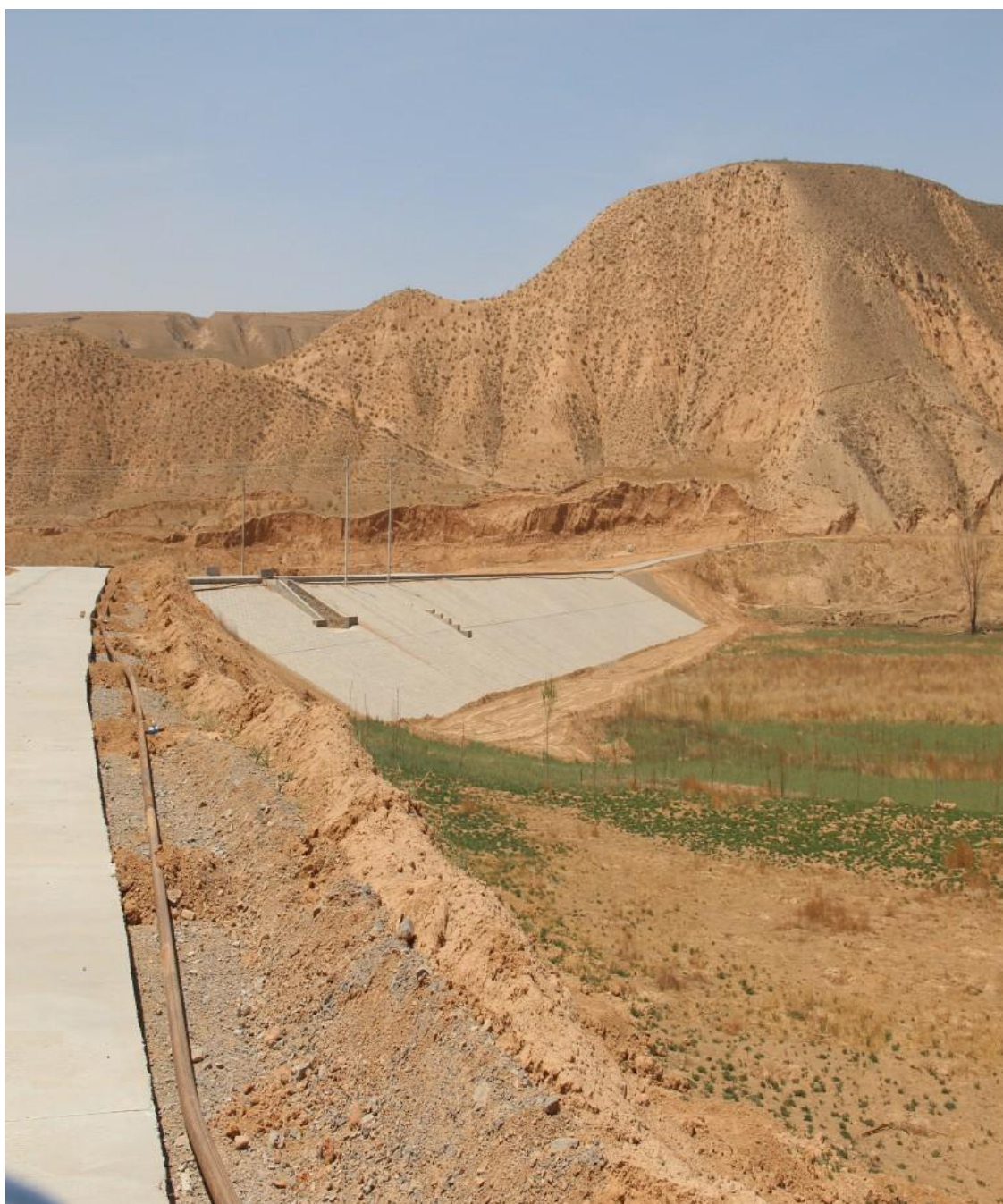
图 5-23 杨新庄水库全景照
