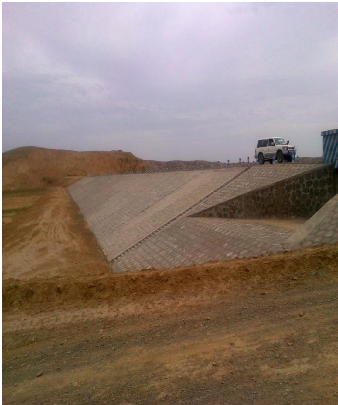
图 5-15 马井水库全景照
