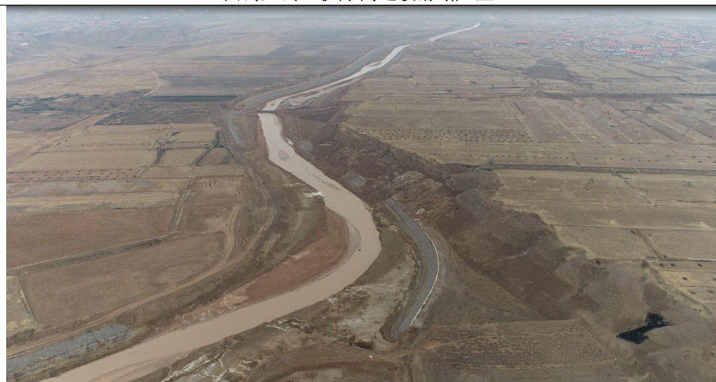
新堡护岸高边坡滑塌严重
